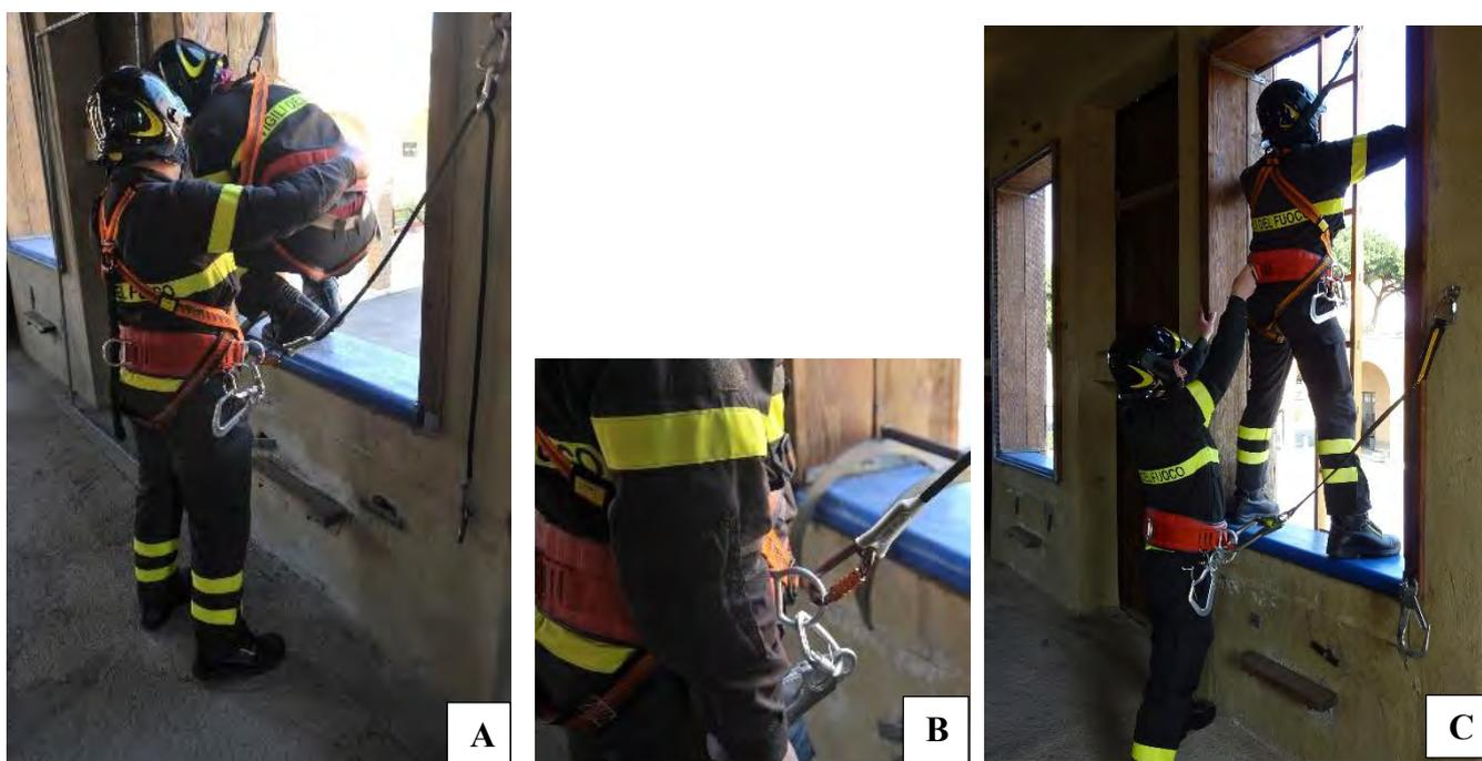
**Figura 7:** *A: Azione di sicurezza ai piani svolta dalle finestre durante le manovre dagli assistenti ai piani B: Particolare dell'anello laterale del cinturone con cui l'assistente viene assicurato ad un cordino di sicurezza vincolato con uno spit-fix o misure equivalenti. C: Assistente vincolato con altro tipo di cordino con assorbitore di energia.*
