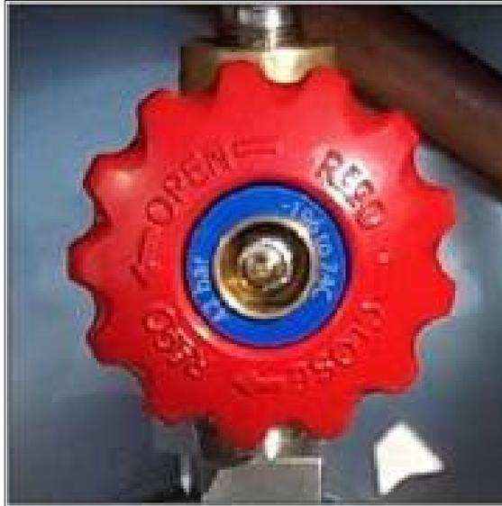
**NON CHIUDERE QUESTA VALVOLA.** In alcuni tipi di serbatoi chiudendo la valvola il prodotto in fase liquida potrebbe rimanere nel vaporizzatore, causando un rapido aumento della pressione. **CHIUDERE SOLO DOPO AVER SCARICATO IL PRODOTTO NEL TRATTO TRA VALVOLA ROSSA ED ELETTROVALVOLA.**
