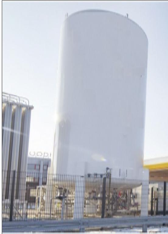
I serbatoi criogenici per GNL sono contenitori ad asse verticale o orizzontale, termicamente isolati, a gruppi di due o più serbatoi.
