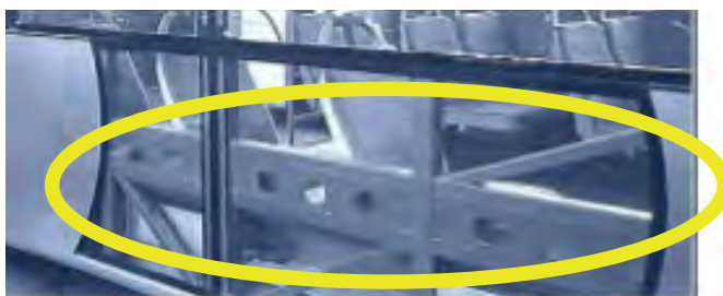
particolare del rinforzo laterale
