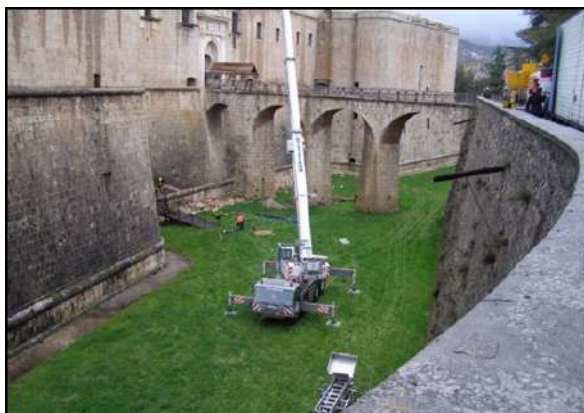
Gru calata nel fossato (Archivio NCP).
