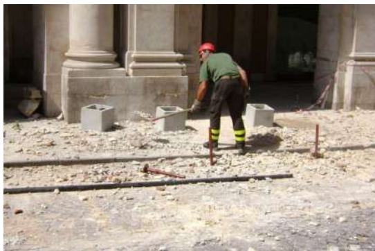
Pulizia del cantiere dalle macerie (Archivio NCP).
