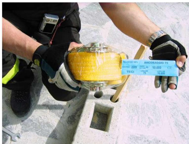
Fasce in poliestere impiegate per la tirantatura.
