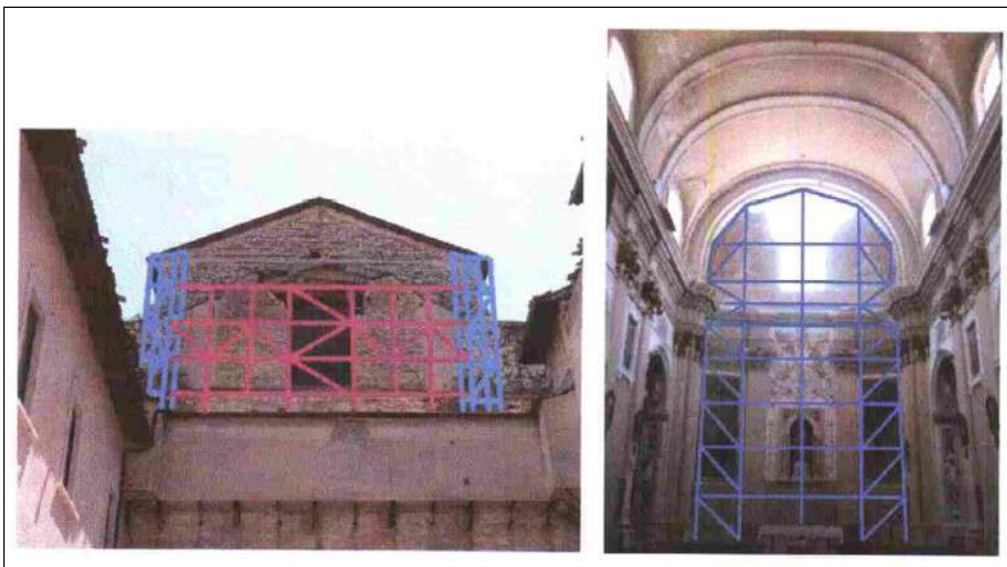
Configurazione geometrica del graticcio ipotizzato (Archivio NCP).
