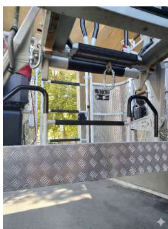
Inserimento connettore in acciaio al punto di attacco centrale
